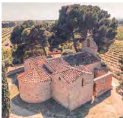
Chapelle de Garrieux
