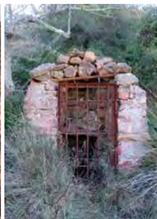
La Fontaine des Douaniers
